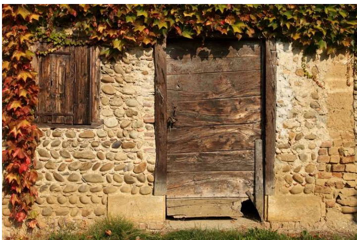
Une porte d'entrée, bâtiment nord.
