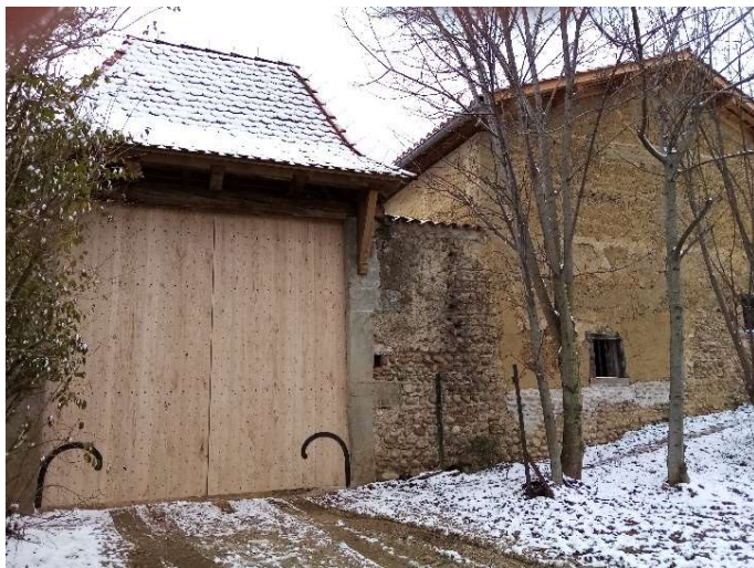
Le porche d'entrée restauré.
